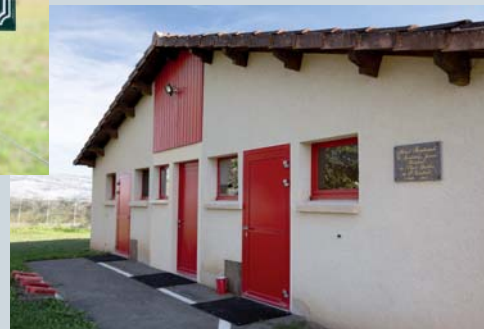
Vestiaires du terrain de foot
